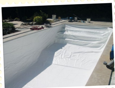
4. La pose du liner
