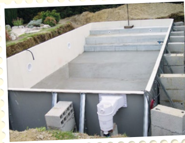
3. La réalisation du profil de fond et l'installation du système de filtration
