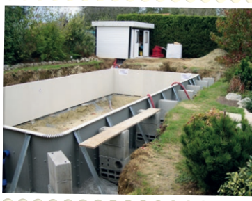
2. Le montage de la structure Steeltech Protec®
