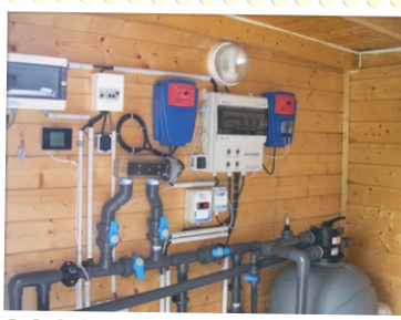
5. L'installation du local technique
